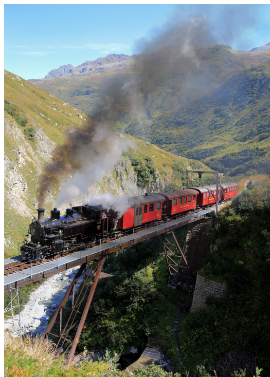
HG 3/4 4 auf der Steffenbachbrücke, 10.Sept. 2012
